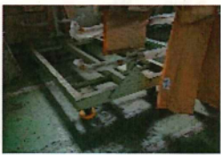
新しくストッパーを用意し設置
